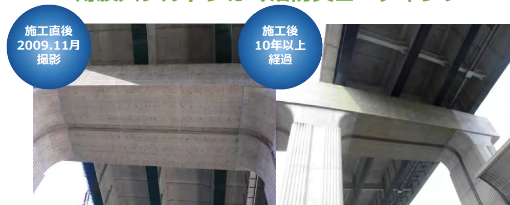
実施モニタリング例：第二京阪道路RCラーメン橋脚横梁部
